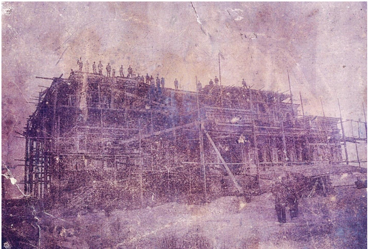
Возведение стен Свято-Воскресенского собора. (Фото сделано где-то 1906-1908 годах при посещении стройки станичным старостой и атаманом урядником Резником)
