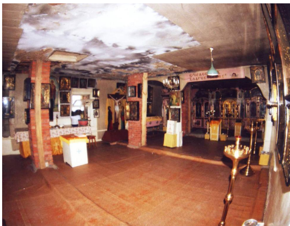
Вид внутри строящегося храма. Саманный молитвенный дом еще не разобран. Фото 1999 года
