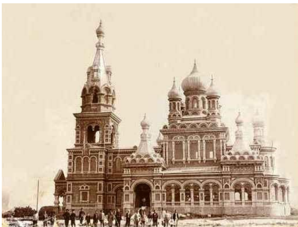
Свято-Воскресенский собор. Вид с южной стороны. Фото 1912 года.
