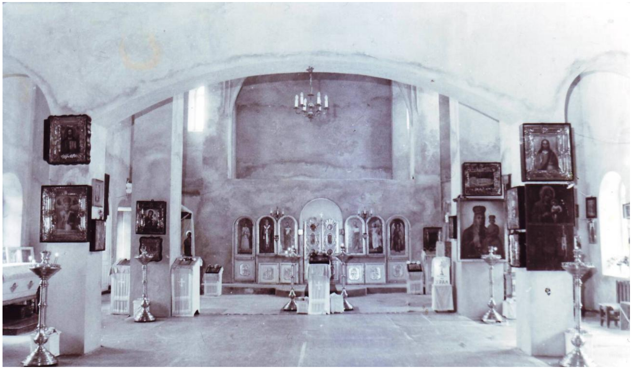
Вид внутри храма после штукатурки стен.
