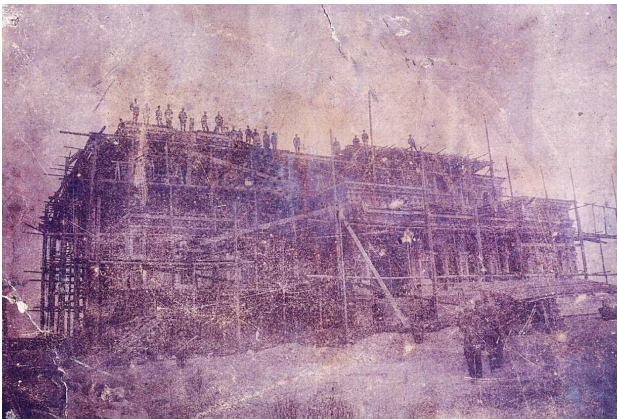
Возведение стен Свято-Покровского собора. (Фото сделано где-то 1906-1908 годах при посещении стройки станичным старостой и атаманом урядником Резником)
